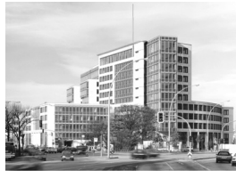
Hochhaus Millerntorplatz 1 Hamburg 1992-1996 A.: Kleffel Köhnhold Papay Warncke 40 Mio €, Tragwerksplanung 1995
