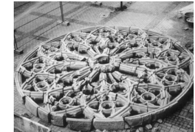
St. Johann, Osnabrück Sanierung, Gutachten, Sicherungskonstruktion 1990-1995 A.: P+R Tragwerksplanung, Projektleitung 1993-95
