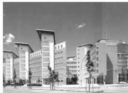
POSEIDON Haus Hamburg Amsickstr. ca. 30 Mio € Prüfung Tragwerk 1990-92
