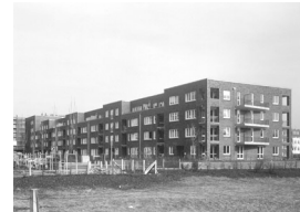
Wohnbebauung Jarrestrasse Hamburg, 1992/93 A.: J. Neumann mit B. Winking Tragwerksplanung
