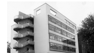
Erweiterung Gesamtschule Hamburg-Neustadt , 1993-2000 A.: Silcher, Werner + Redante 8,4 Mio €, Tragwerksplanung, Projektleitung 1. BA 1993-95
