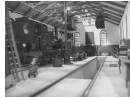
Wartungshallen mit Werkstatt Bahnhof Neumünster Tragwerksplanung, Projektleitung 1993
