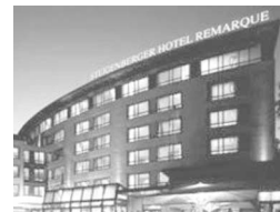
Centrum am Natruper Tor Wall Osnabrück, Tragwerksplanung 1992
